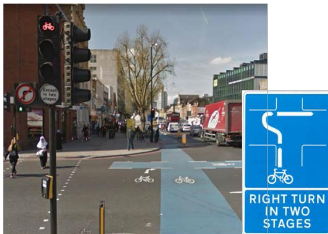
Slika 4. Primena rešenja dvostepenog kretanja u raskrsnici.
