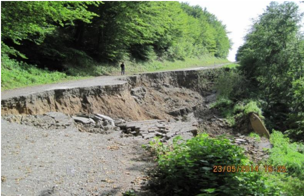
Слика 3. Клизиште на државном путу IIА-137 Крупањ - Мачков Камен - Грачаница, км:6+900. Клижењем је потпуно уништен труп пута у дужини од 60м
