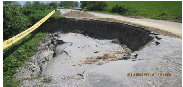
Слика 6. Клизиште на државном путу IIА-170, деоница: Ваљево - Дебело брдо, км:22+200, настало након мајских поплава 2014. год.
