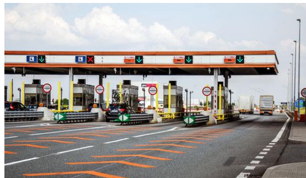
Slika 2. Sistem elektronske naplate putarine koji zahteva redukciju brzine Izvor: www.kapsch.net
