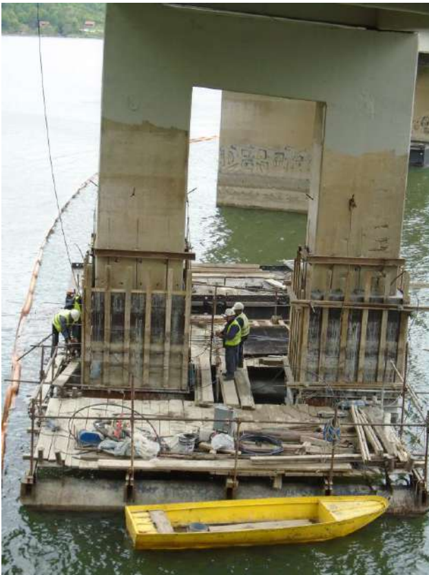
Слика 10. Постављање оплате за бетонирање облоге стуба изнад воде са пловеће платформе.
