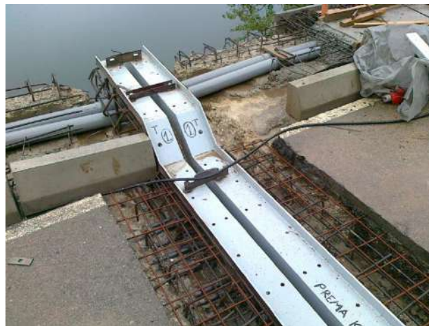
Слика 2. Постављање дилатационе справе МТ-70
