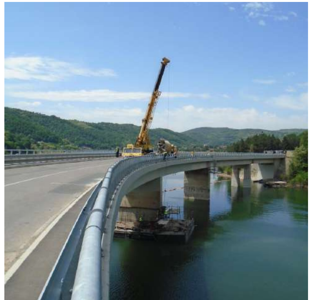
Слика 11. Организација бетонирања облоге стуба у води.
