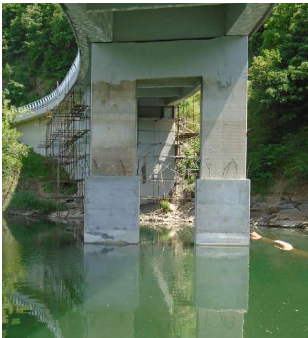
Слика 13. Изведени бетон облоге стуба изнад воде.
