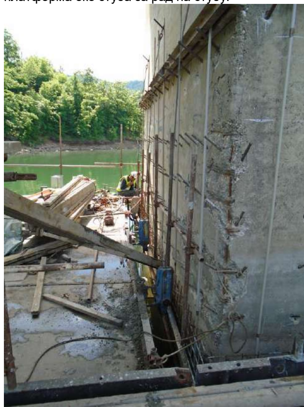
Слика 9. Уградња анкера за везу облоге стуба са старим бетоном стуба.
