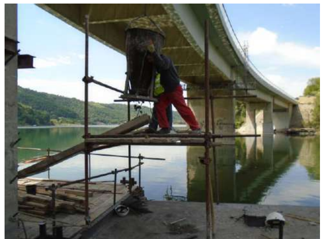
Слика 12. Бетонирање облоге стуба у води са пловеће платформе.
