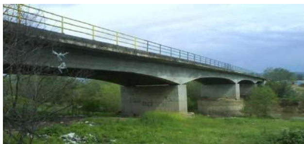
Слика 3. Узводи изглед моста
