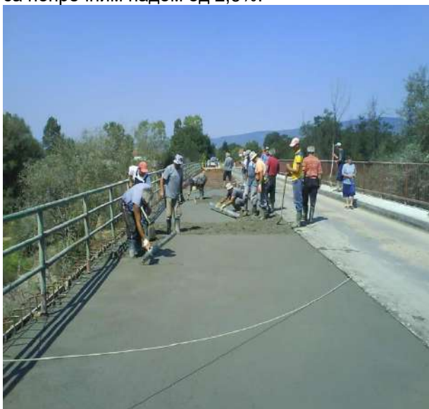
Слика 6. Бетонирање надградње коловозне плоче
