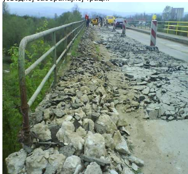
Слика 4. Рушење пешачке стазе и L/2 асфлата коловоза
