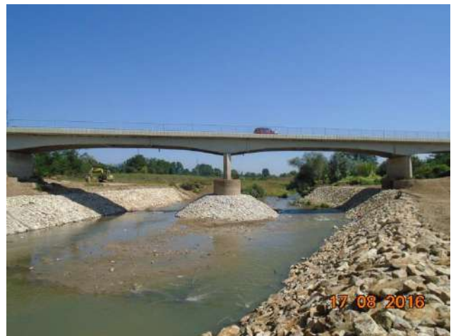
Слика 13. Регулација корита реке Ј. Мораве у зони моста
