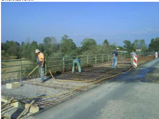
Слика 5. Постављање надградње арматуре коловозне плоче
