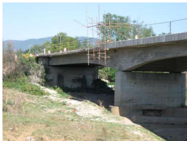
Слика 7. Постављање монтажних венаца пешачких стаза
