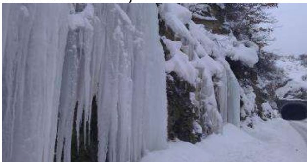
Slika 13. Ledene naslage u predusecima tunela
