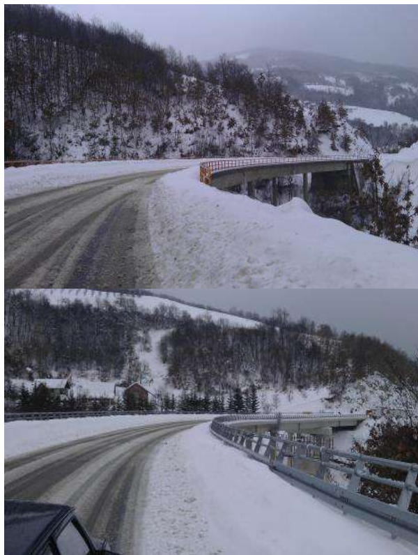
Slika 11. Mostovi na Jadranskoj magistrali IB-22 posle većih snežnih padavina
