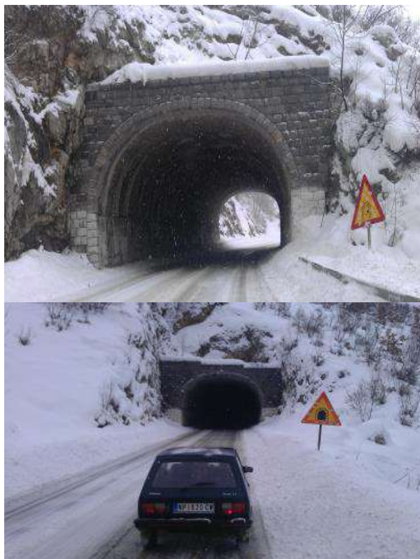
Slika 12. Tuneli na Jadranskoj magistrali IB-22 posle većih snežnih padavina
