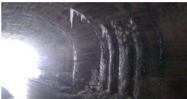
Slika 14. Ledenice u tunelima na IB-22
