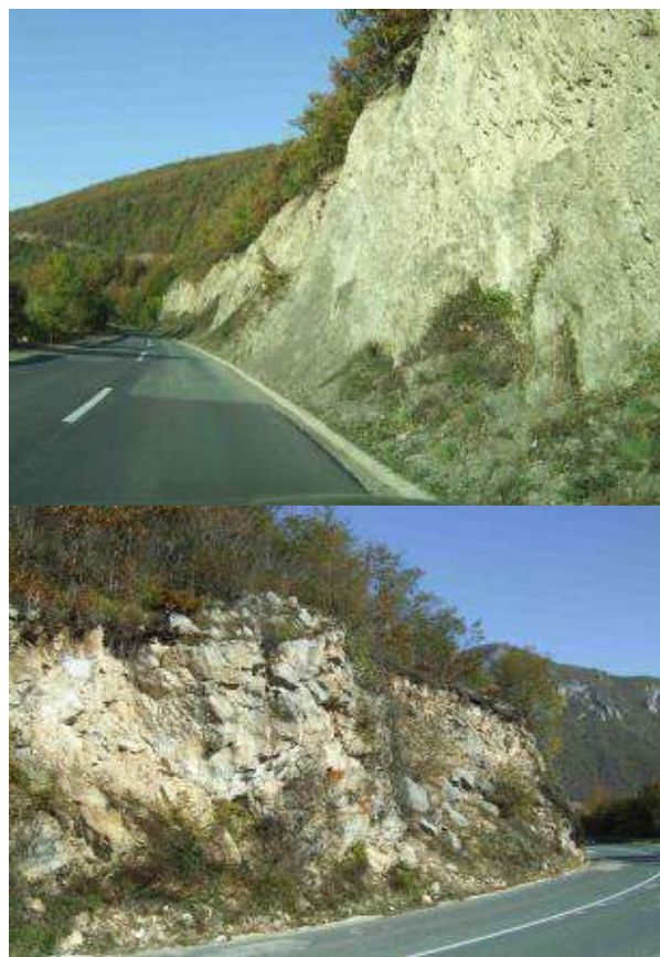
Slika 9. Neuređene kamene kosine duž Jadranske magistrale IB-22 i IB 32
