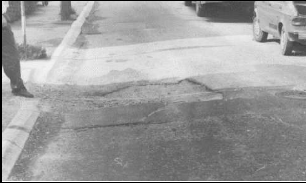
Slika 13 –udarna "rupa" na kolovozu [10]
