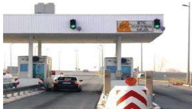
Слика 9: Посебна трака само за ETC / DSRC систем наплате путарине у Србији (Извор: www.putevi-srbije.rs)
