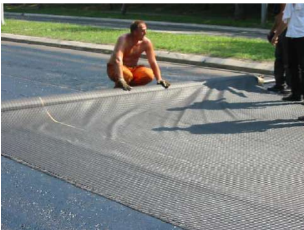
Слика 6. Детаљи постављања мрежа и уграђивања хабајућег асфалтног слоја (Тривић, 2005.)
