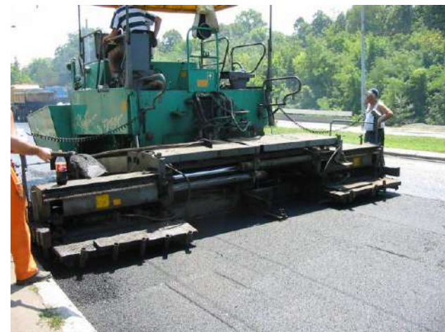
Слика 6. Детаљи постављања мрежа и уграђивања хабајућег асфалтног слоја (Тривић, 2005.)
