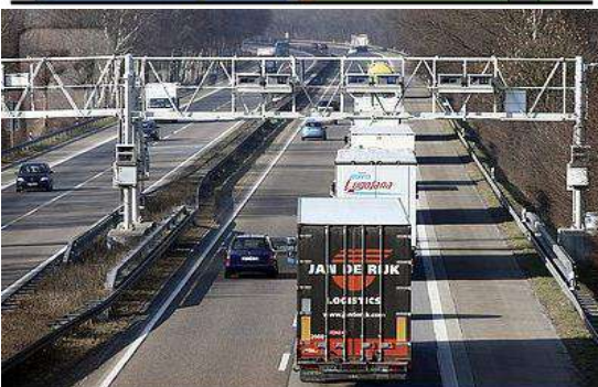
Слика 7: Изглед и систем функционисања MLFF / DSRC наплате путарине
