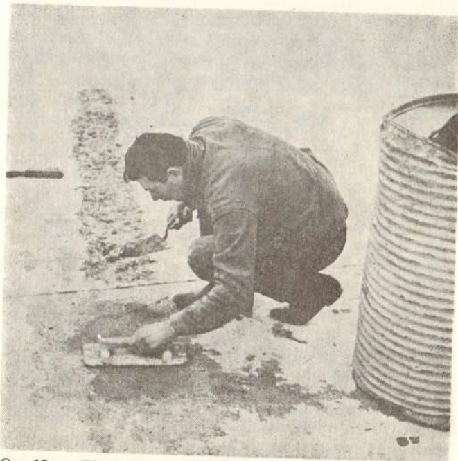
Сл. 12 — Поправка оштећења површинског слоја цементнобетонског коловоза епоксидним малтером
