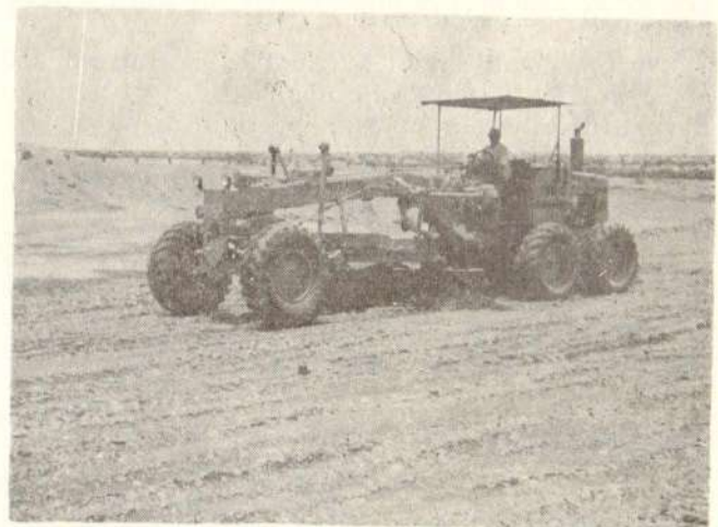
Сл. 9 — Разастирање и планирање горње подлоге од песковито-шљунковитог материјала помоћу грејдера
