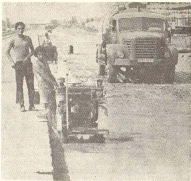
Сл. 7 — Сечење слоја од цементом стабилизованог шљунка
