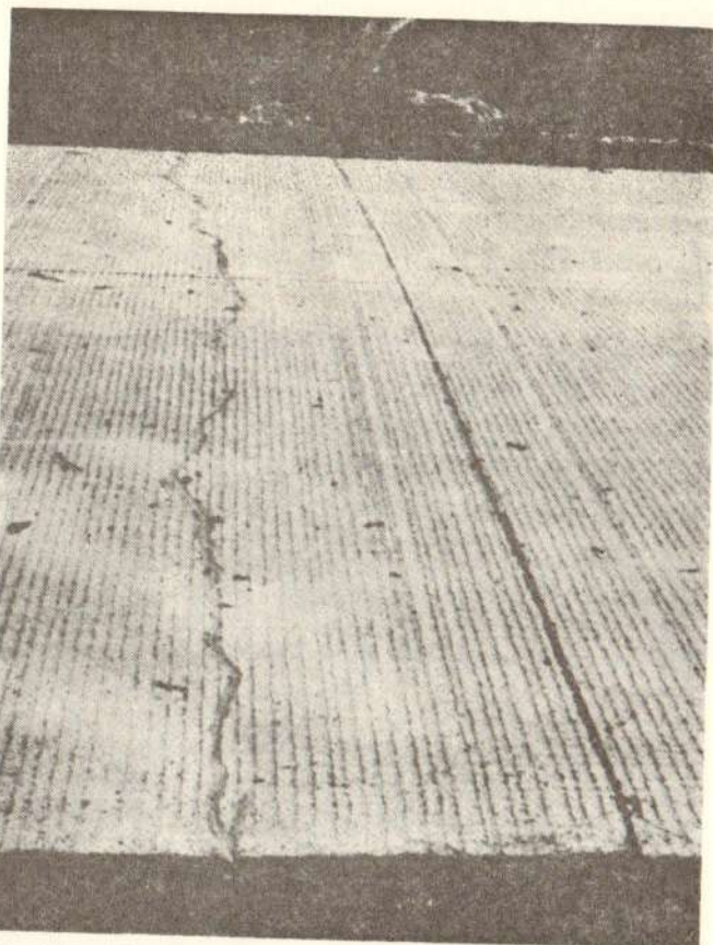
Сл. 11 — Попречна прслина после санације без обраде завршног слоја
