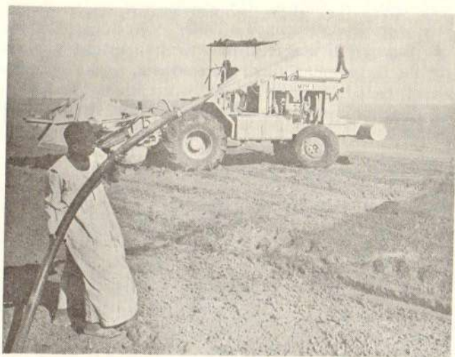
Сл. 7 — Поливање земљаног материјала да би се омогућило набијање
