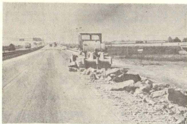
Сл. 6 — Растресање и раздвајање бетонских блокова рипером
