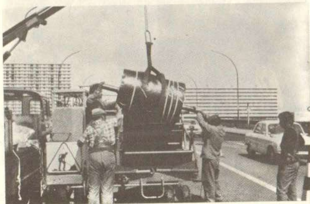
Сл. 4 — Ушовар шрака у уређај за постављање префабрикованог застора
