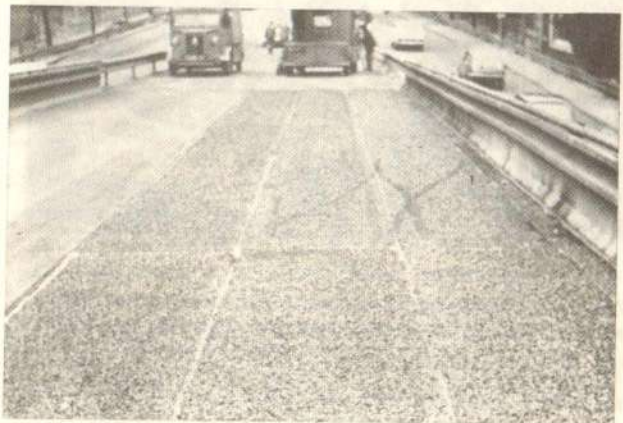
Сл. 9 — Нови коловозни застјор од префабрикованог асфалтног тепиха преко металне табле моста
