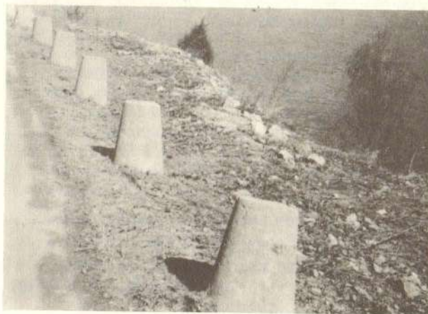
Сл. 3 — Постојећи колобрани на путу поред Златиборског језера не могу увек да задрже возило у случају скретања
