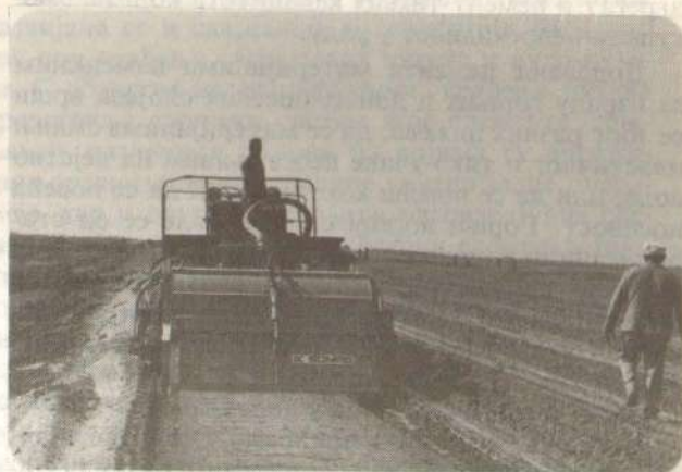
Сл. 3 — Стицање и мешање материјала с кречом ројлофрезером
