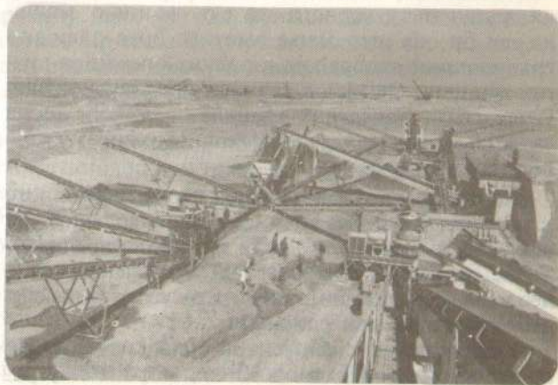
Сл. 4 — Дробилишно постројење савременог типа
