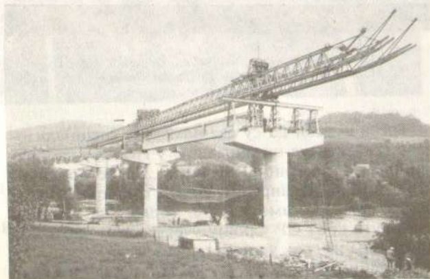
Сл. 9 — Навлачење преднапрећујућег носача на полуауто-путу Зеница—Сарајево („Стиг“)
