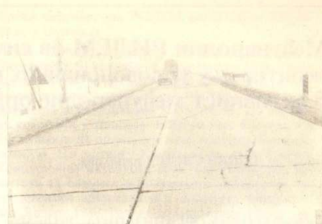
Сл. 4 — Израда цементно-бетонских плоча на постојећем коловозу пре дробљења
