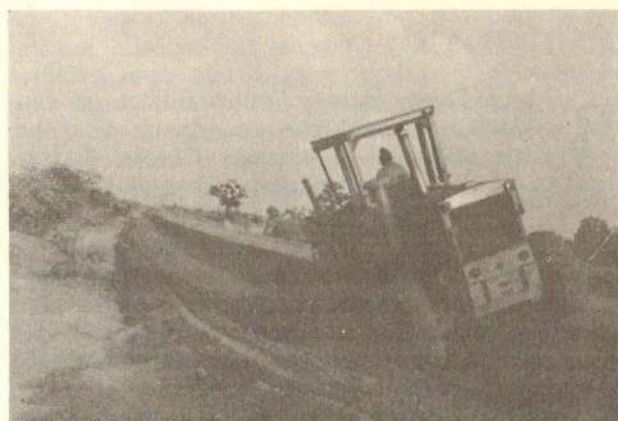
Сл. 2. Ископ канала (позајмишће материјала) дуж пута
