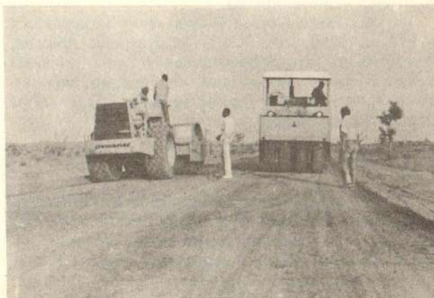
Сл. 3. Изградња коловозне конструкције од латерита
