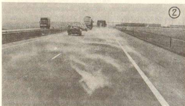
Сл. 6. Изглед коловоза у току посипања влажне соли (6-1) и суве соли коју струјање ваздуха возила при пролазу одбацује са коловоза (6-2)
