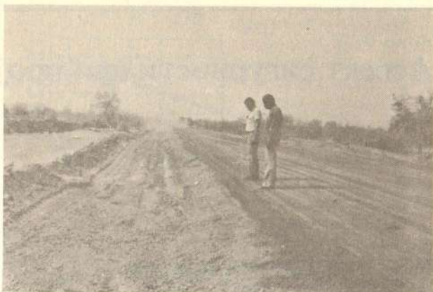
Сл. 5. Изглед завршеној пута са заштитом од бијелих површинске обраде
