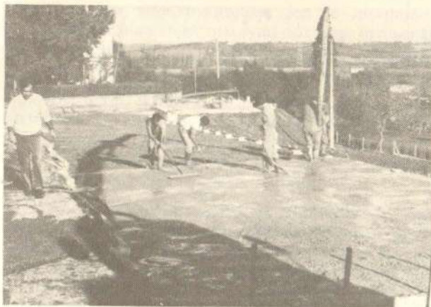
Сл. 11. Израда армиранобетонске плоче
