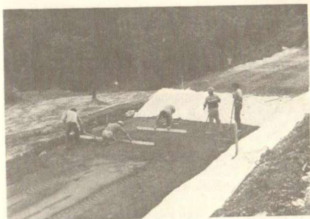
Сл. 9. Постављање геотекстила и слоја песка као подлоге насипу од експандираног полистирена
